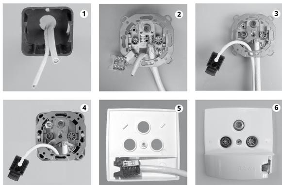
1. Dejar un mínimo de 15cm de cable (coaxial y datos) fuera de la caja de mecanismos. Cortar aproximadamente 3cm del cable coaxial, dejando el cable de datos con los 15cm.
